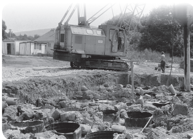
Foto 16 Betónovanie pilót pod hotel – jún 1984
