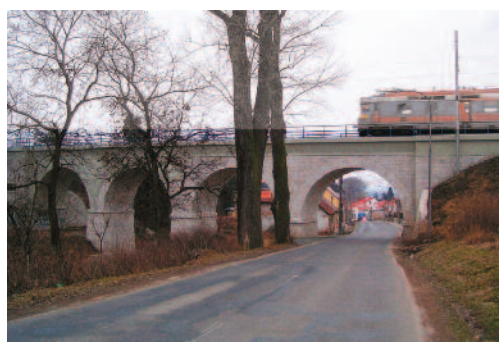
Železniční viadukt po rekonstrukci (r. 2003)
